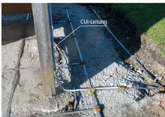
Bild 7 Isolierter Blitzableiter (CUI-Leitung) in der Anwendung
