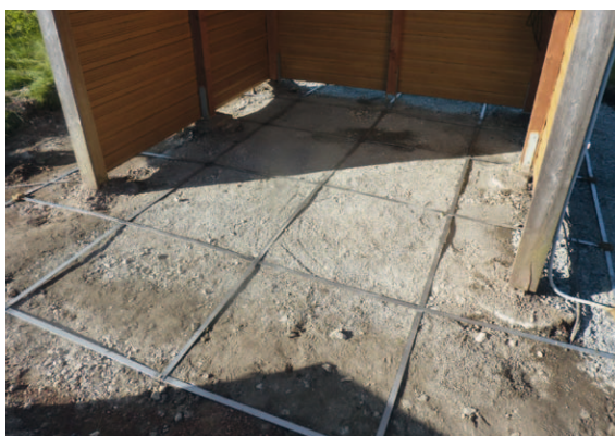
Bild 6 Potentialsteuerung einer Schutzhütte
